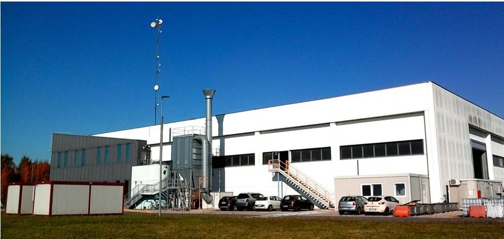
Vista dell’impianto da sud
