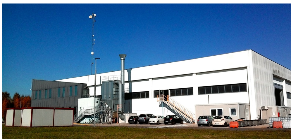
Vista dell'impianto da sud
