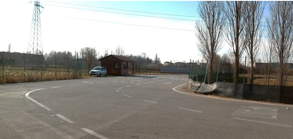
Ingresso impianto (area pesa)
