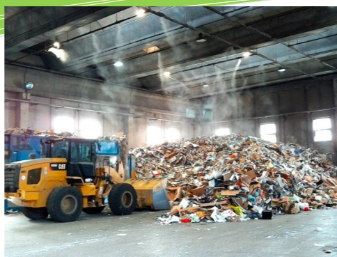
Zona conferimento e carico del rifiuto
