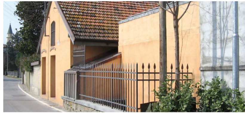
L'esterno della centrale External view of the plant
