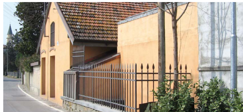
L'esterno della centrale External view of the plant
